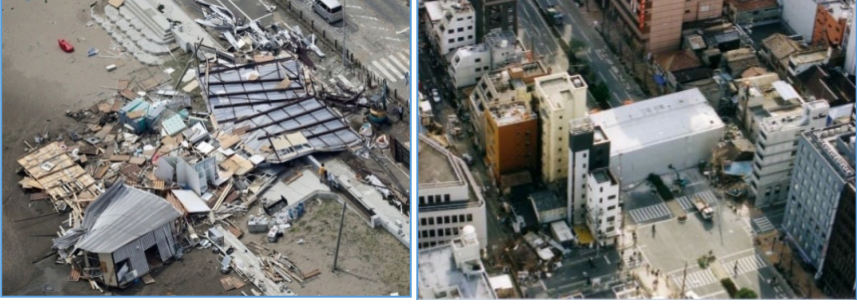
Şekil 2. a. Faxai Tayfunu, 08.09.2019 (Victor, 2019). b. Büyük Hanshin-Awaji (Kobe) Depremi (17.01.1995) sonrası araç yoluna devrilen bina (Tokyo Kentsel İmar Bürosü, Dirençli Kentler Forumu, 2019).
