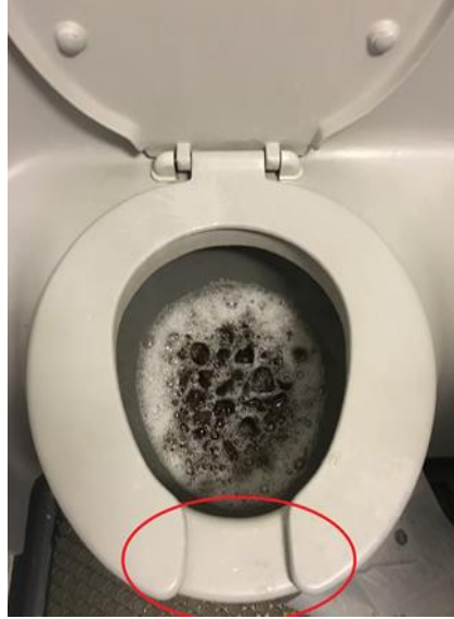
Resim 2. Kazadan Sonra Değiştirilen Klozet Yapısı
