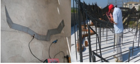
Şekil 3. Enkesitlerin imal edilmesi ve yerleştirilmesi
