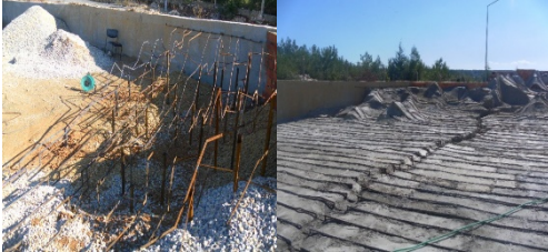
Şekil 5. Mansap bölgesinde kesitlerin yerleştirilmesi ve dolgu malzemesiyle doldurulması
