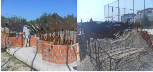
Şekil 4. Göl bölgesinin duvarla örülmesi ve dolgu malzemesi ile doldurulması
